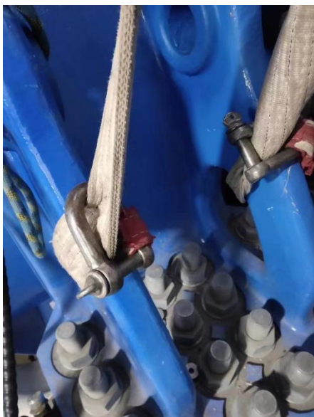
钢丝绳锚地情况检查
