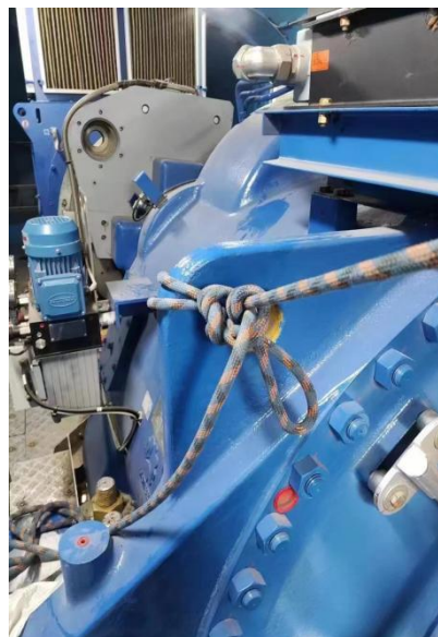
安全绳锚点检查
